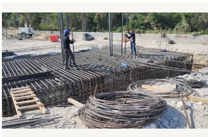
Habilitado de acero de refuerzo.
