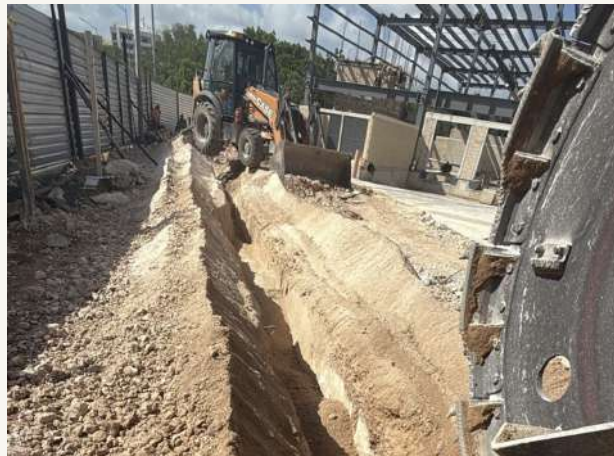
02 • Terracerías y zanjado de alta capacidad
