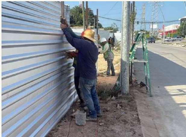
01 • Obras preliminares y confinamiento
