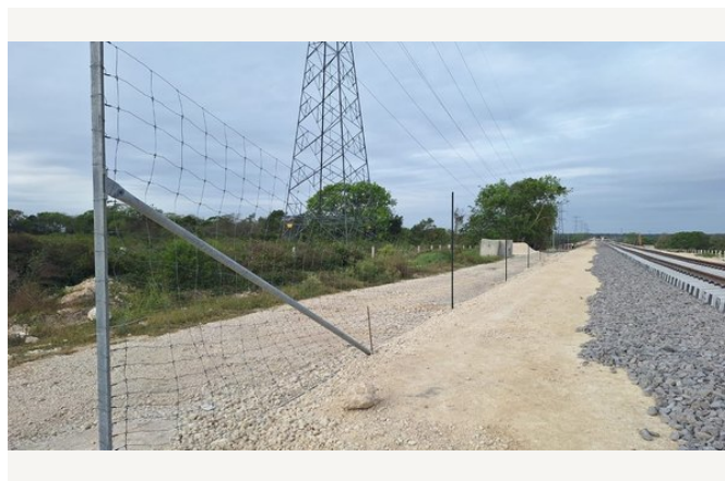
Confinamiento perimetral junto a la vía férrea.
