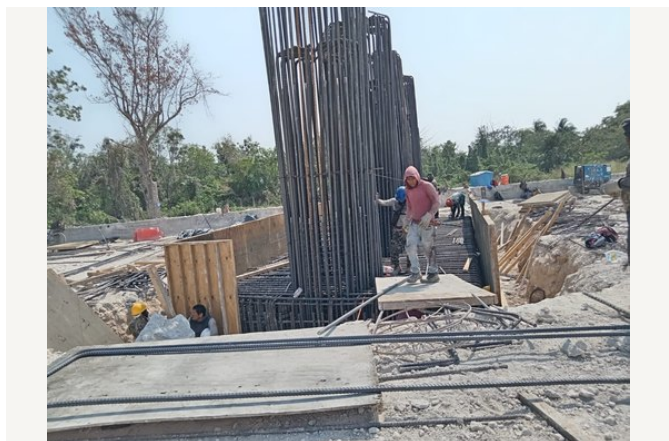
Cimbrado de elementos de cimentación.
