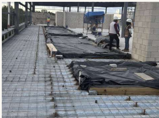
06 • Cimbrado especializado en áreas frigoríficas
