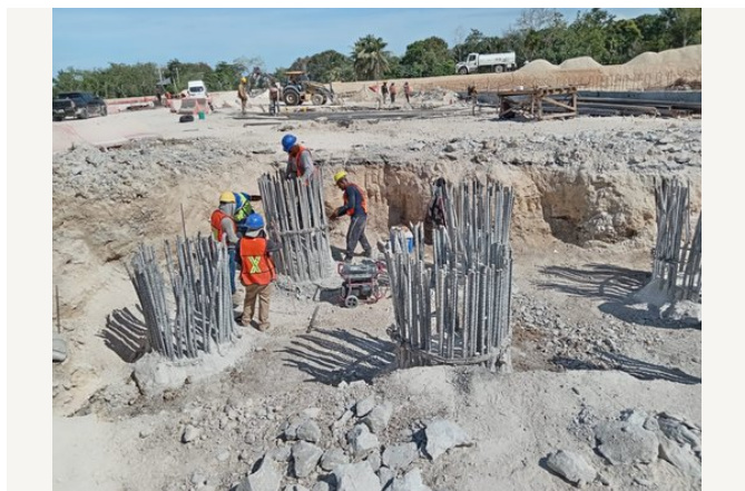
Trabajos en elementos de cimentación profunda.
