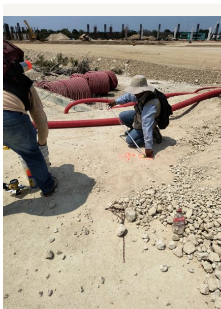
Trazo, nivelación y ductería.
