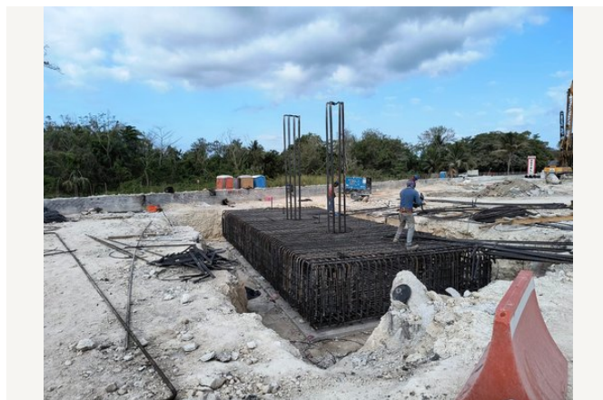
Armado de acero de refuerzo para cimentaciones.
